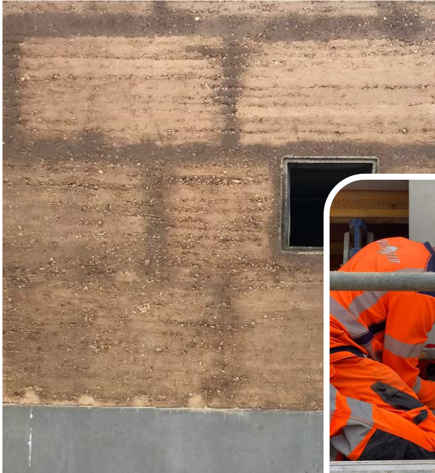
Remplissage des joints
