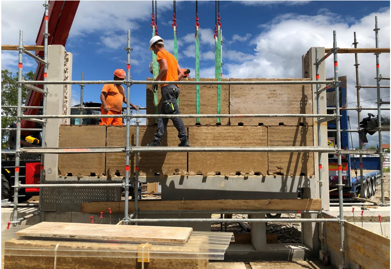
Pose des modules préfabriqués
