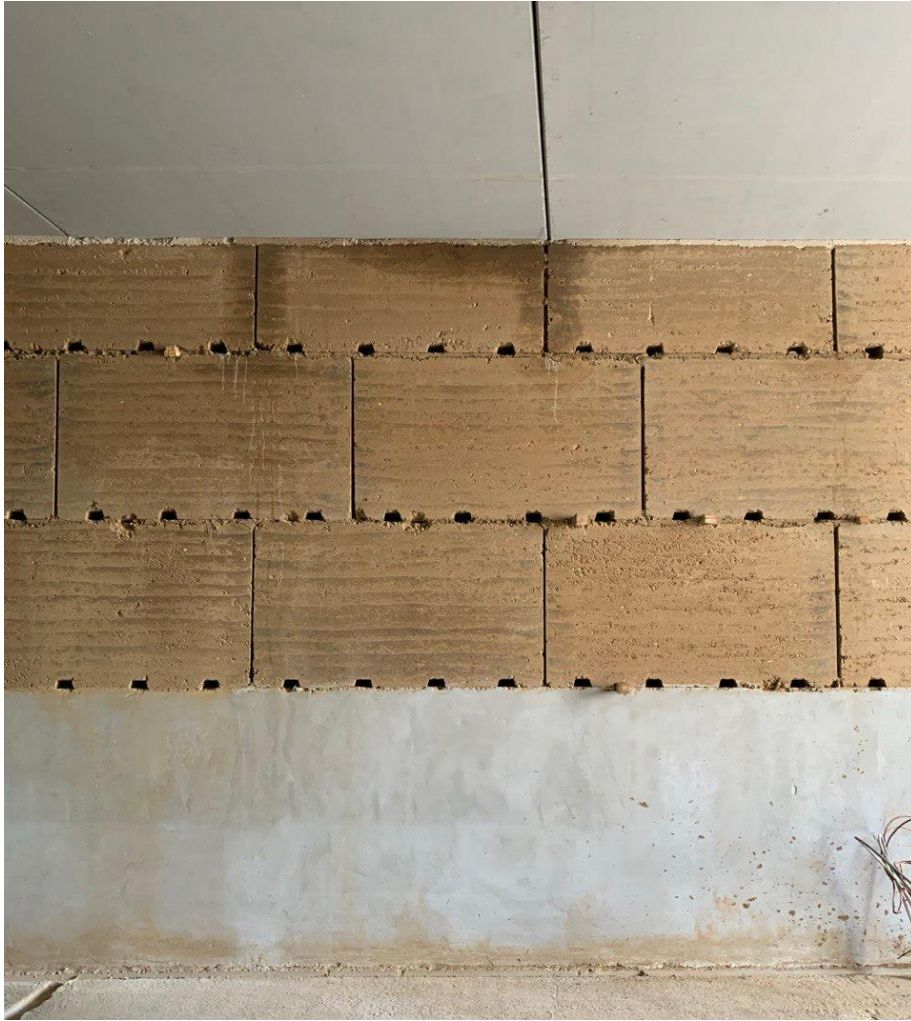
Etat intermédiaire avant remplissage des joints
