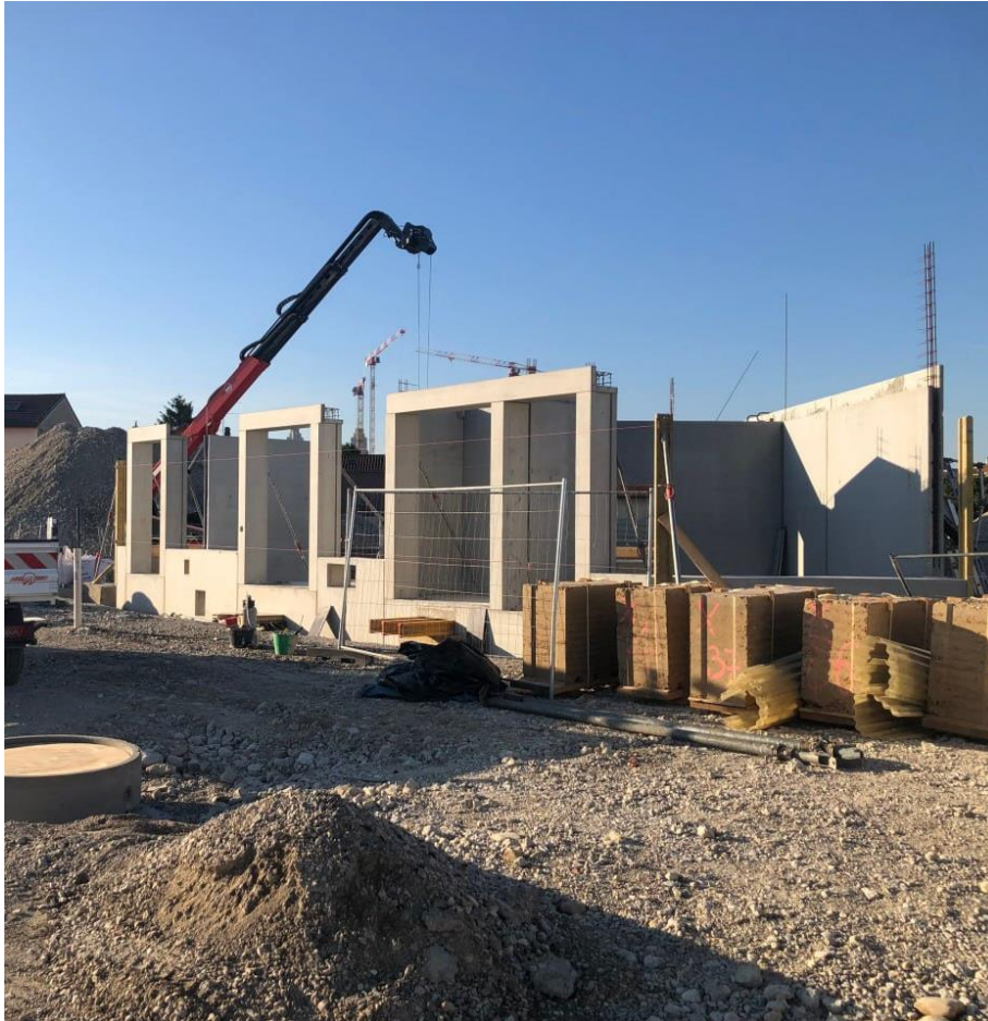
Fondation et structure béton
