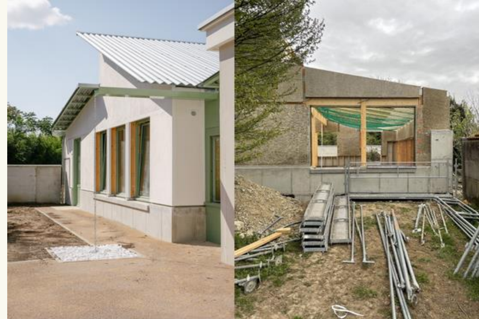
Extension de l'école maternelle St Exupéry, Villeurbanne (69)
