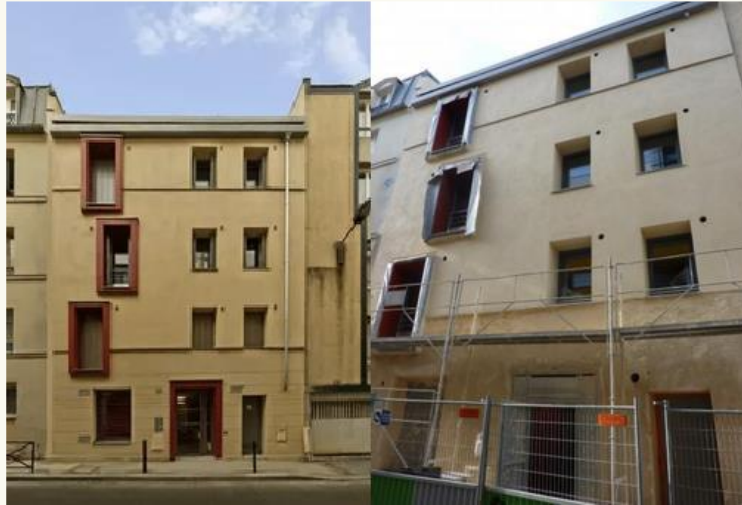
Construction neuve de logements en béton de chanvre, Paris (75)
