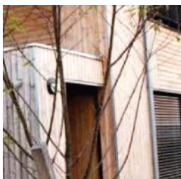
Bardage bois (Revêtement extérieur)
