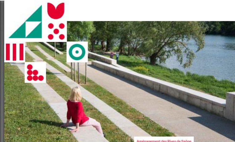
Aménagement des Rives de Saône
