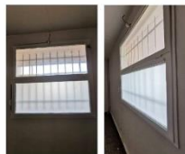
Fenêtres cadre bois, issues d'une déconstruction à Dijon. Utilisées pour être en chaux-craie.
