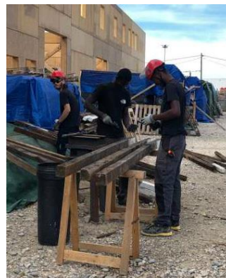
Bois de charpente et planches : tri, retrait des pointes
