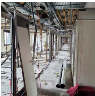
Collecte sélectionnée sur chantiers de déconstruction
