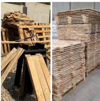
Démantèlement Tri - stockage
