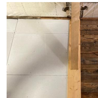
Pose de plaques de parement : chutes de fermacell
