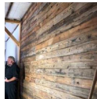
Pose de lambris : planches brossées
